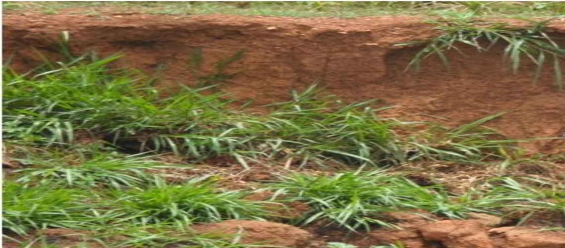
Figura 5: Erosão localizada ao lado da nascente Fonte: Márcia Rosa, 2014.
